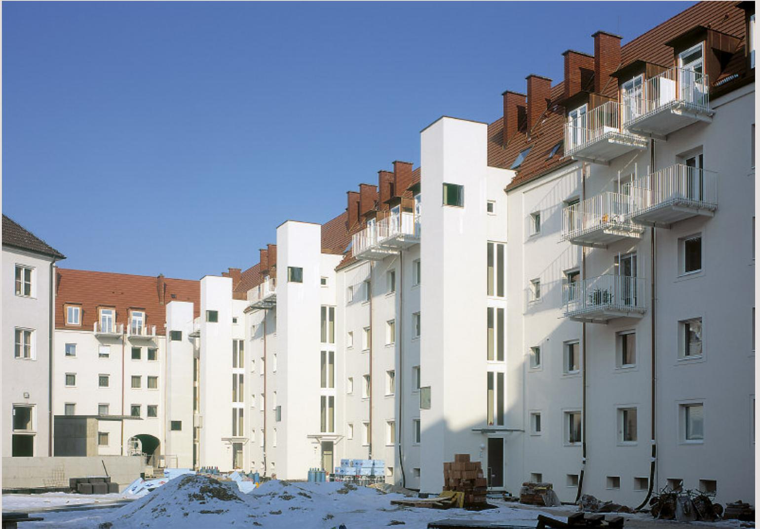
Sanierung und Ergänzung des Markarthofes in Linz durch den Anbau von Liftanlagen, den Ausbau von Dachgeschoßen und den Bau einer Tiefgarage. Realisiert nach den Plänen des Architekten Franz Riepl, 2001 bis 2006
